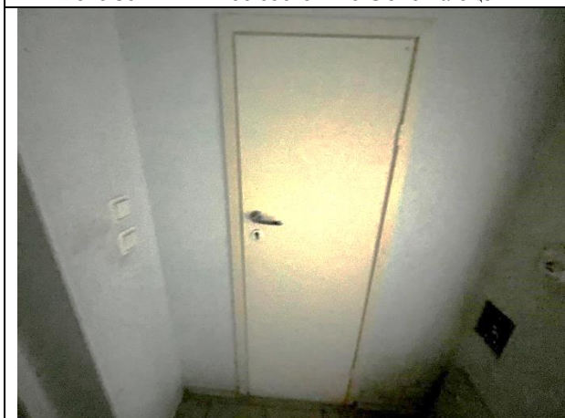
Фото 37. Типичное состояние Объекта оценки
