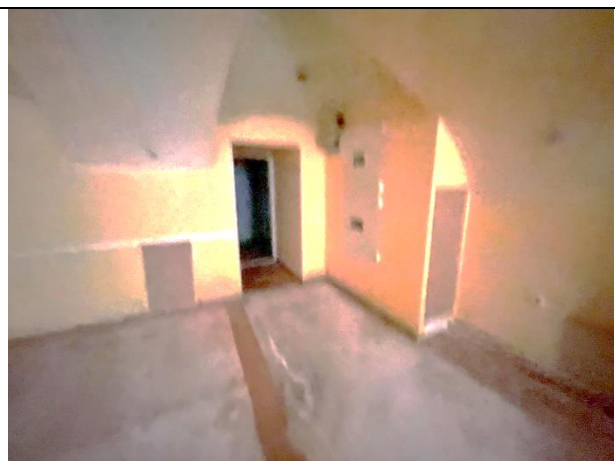
Фото 24. Типичное состояние Объекта оценки
