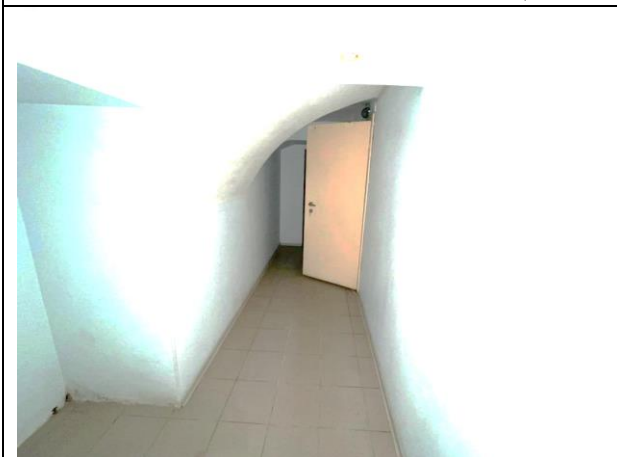
Фото 25. Типичное состояние Объекта оценки
