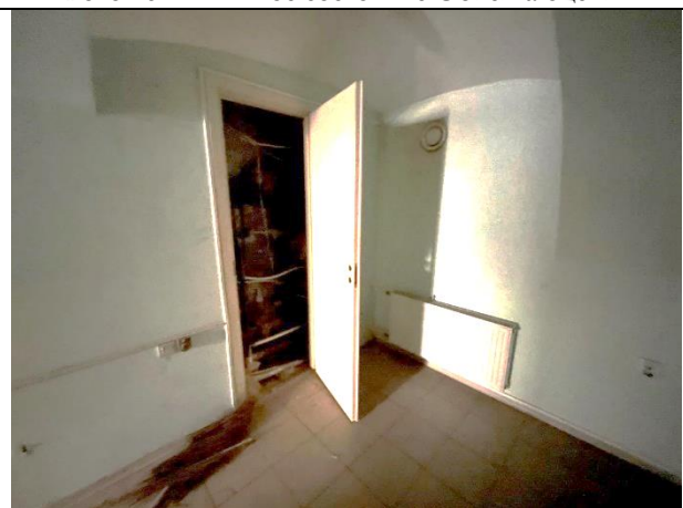
Фото 18. Типичное состояние Объекта оценки
