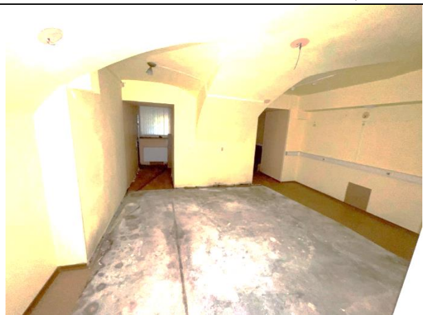
Фото 26. Типичное состояние Объекта оценки
